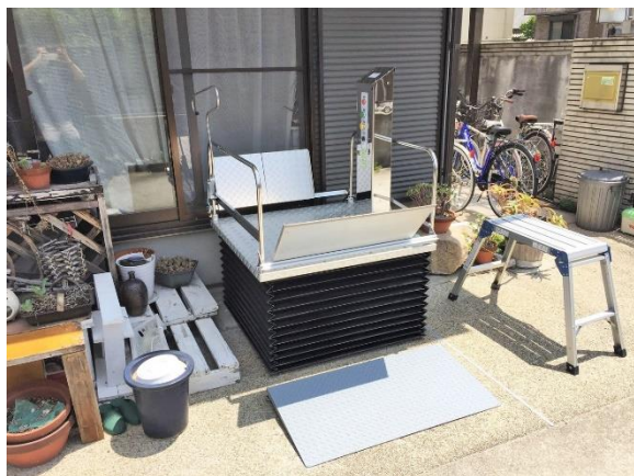
掃き出し窓へ昇降機を設置 ＋電動車いす
